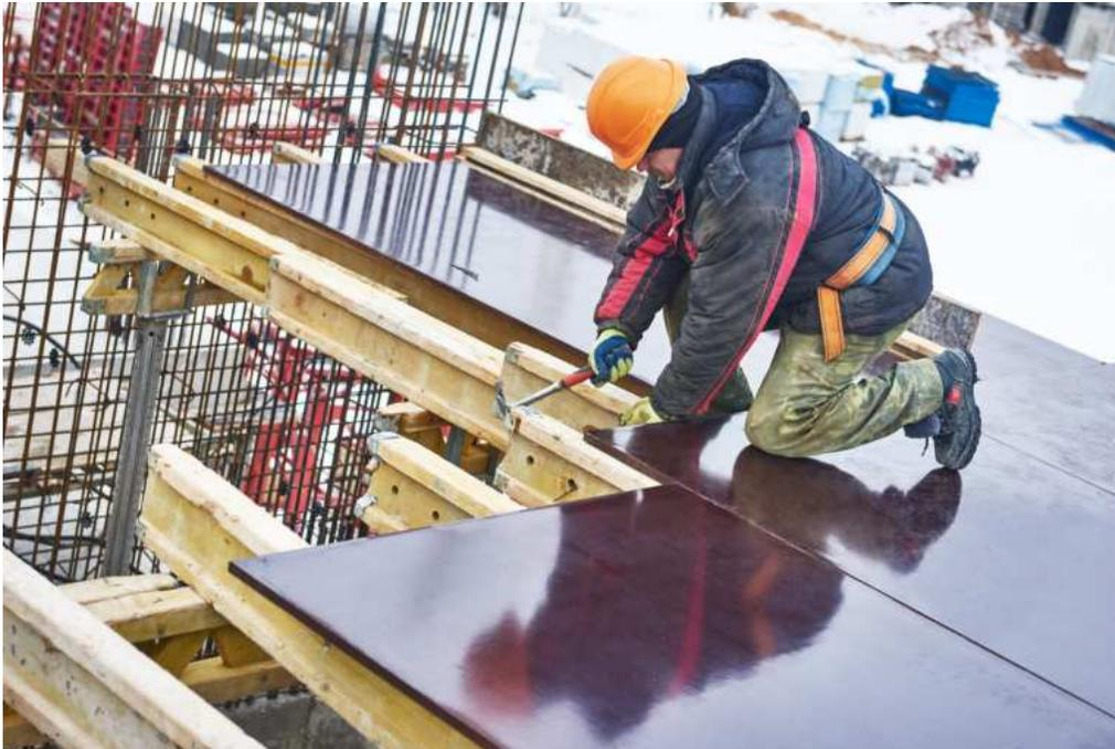
Tableros de madera contrachapada de álamo o abedul de alta calidad, fabricada con una superficie de fibra impregnada con pegamento fenólico o melamina en ambas caras con propiedades de película protectora. La superficie es lisa, sus cantos están cubiertos con pintura para proteger la madera de la humedad y el agua. Se monta con rapidez y es fácil de tratar.
